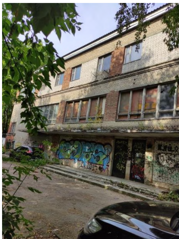
Рисунок 7 – Фотофиксация существующего состояния территории (вид 4)
