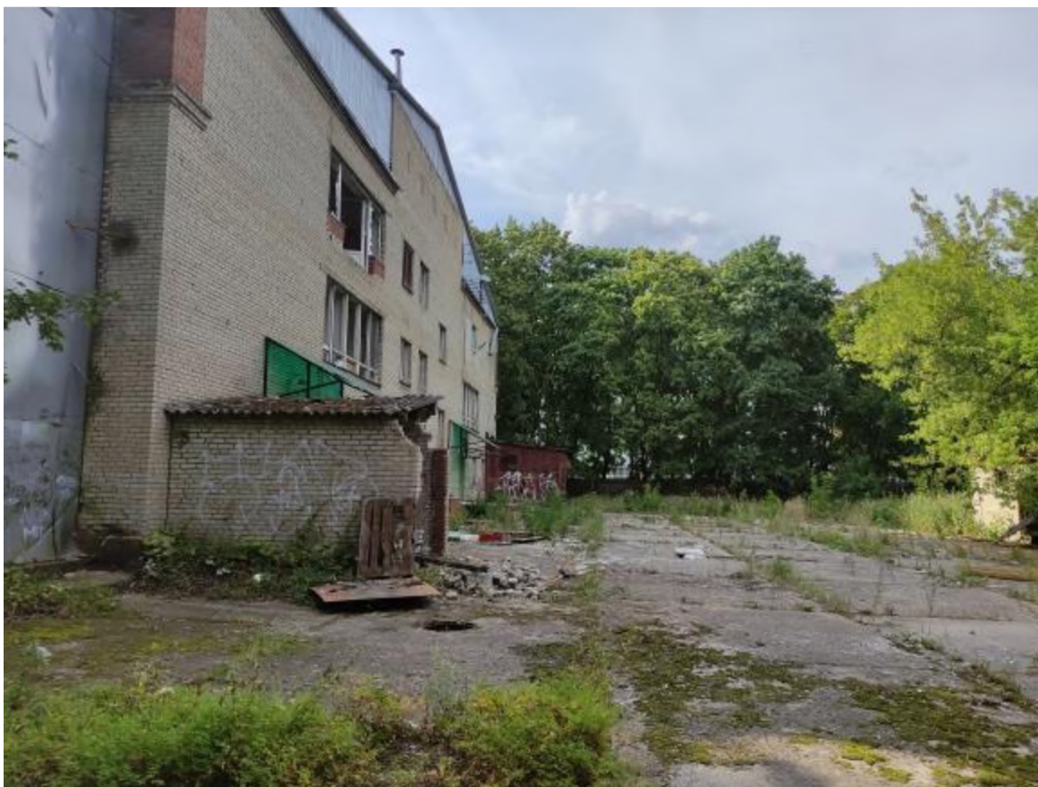
Рисунок 4 – Фотофиксация существующего состояния территории (вид 1)
