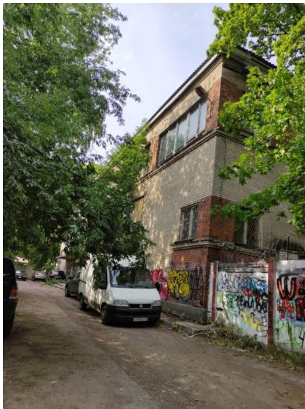
Рисунок 6 – Фотофиксация существующего состояния территории (вид 3)
