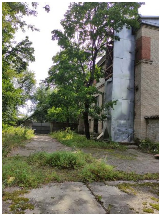
Рисунок 5 – Фотофиксация существующего состояния территории (вид 2)
